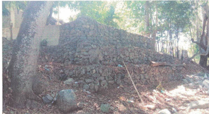
REPARACION DE MURO DE CONTENCIÓN
