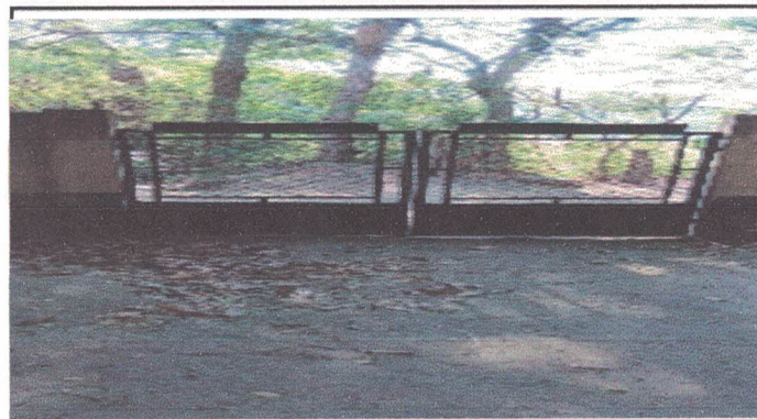
SUSTITUCION DE PORTON DE PORTON DE METAL DE INGRESO
