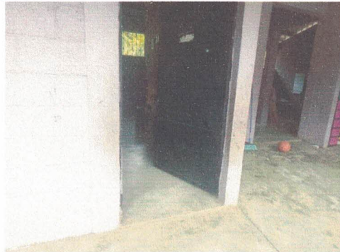
Foto 2: Cambio a PISO CERAMICO ANTIDESLIZANTE para MODULO DE AULAS, DIRECCIÓN, CORREDOR DE AULAS Y EN COCINETA.
