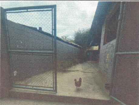
Foto 5: Mantenimiento Correctivo a Portón de Marco de Tubo y Malla Galvanizada Y Balcones Metalicos. Debiendose Lijar, quitar Pintura y Aplicar 2 MANOS DE PINTURA ANTICORROSIVA COLOR SEGÚN SUPERVISOR.
