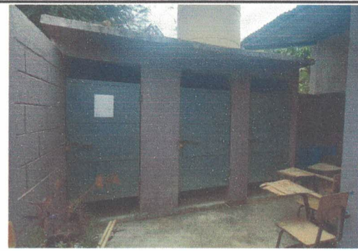
Foto 4: Este Renglon contempla la Reparación, Lijando la Pintura Existente y la Aplicación de Pintura Anticorrosiva en 2 Manos para Puertas y Balcones, así como tambien cambio de 2 Chapas.
