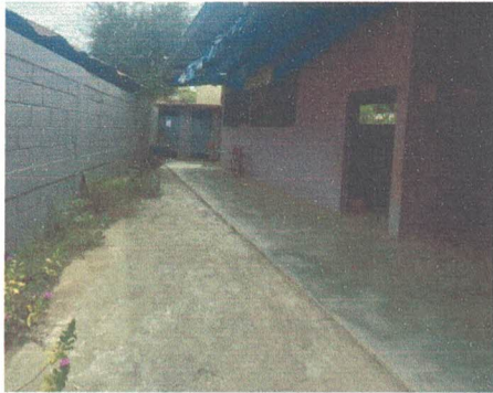
Foto 1: Tramiento a Base de Piso Liquido Existente para Cambio a PISO CERAMICO ANTIDESLIZANTE para MODULO DE AULAS, DIRECCIÓN, CORREDOR DE AULAS Y EN COCINETA.
