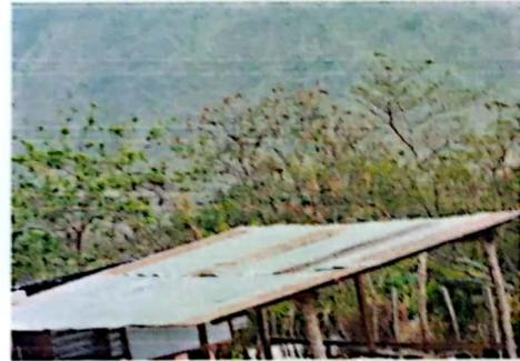
Foto 4: SUSTITUCION DE LAMINA, POR LAMINA TROQUELADA ALUZING CALIBRE 26
