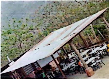
Foto 3: SUSTITUCION DE LAMINA, POR LAMINA TROQUELADA CALIBRE 26, LAS FOTOS 1,2,3,4, SON DEL MISMO MODULO AL CUAL SE HARA EL CAMBIO DE TECHO
