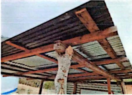
Foto 1: SUSTITUCION DE ESCSTRUCTURA DE MADERA POR METAL
