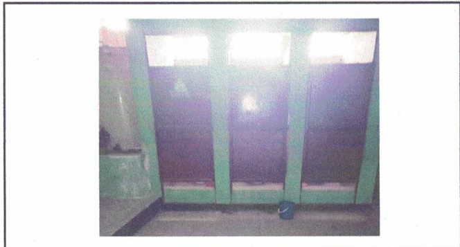
2.1 mantenimiento a puerta de metal
