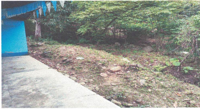
Foto 1: Reparación muro de contención
