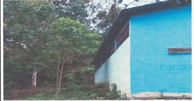
Foto 2: Sustitución de lámina
