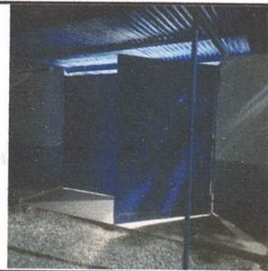
Foto 6: Reparación de Acceso, con costaneras y Lamina de Troquelada.
