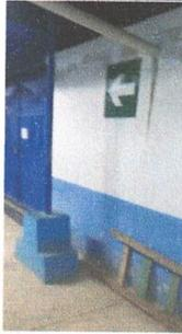
Foto 1: Reparación de Zocalo contra el Salitre en Paredes, sustitución de Zocalo con Fachaleta cerámica.
