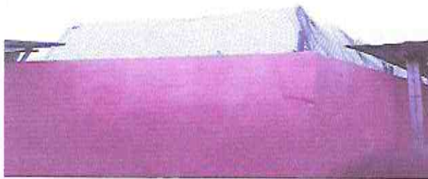
Foto 5: Reparacion de muro perimetral de block
