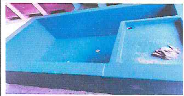
Foto1: Reparacion y mantenimiento de cisterna/ depositos de agua
