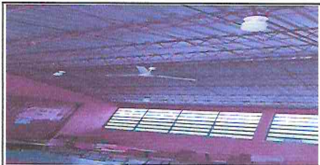
Foto 6: Reparacion de sistema electrico
