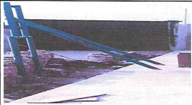
Foto 4: Mantenimiento de portones
