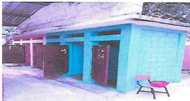
Foto 3: Pintura en muros Exteriores e interiores
