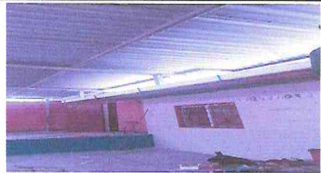
Foto 2: Canales y bajadas de agua pluvial
