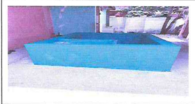
Foto1: Reparacion de cisterna de concreto (pintura para piscina sherwin williams)
