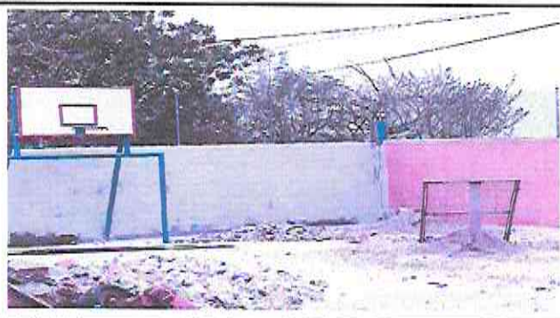
Foto 3: Pintura en muros Exteriores e interiores
