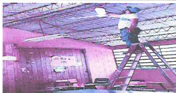
Foto 6: Reparacion de sistema electrico
