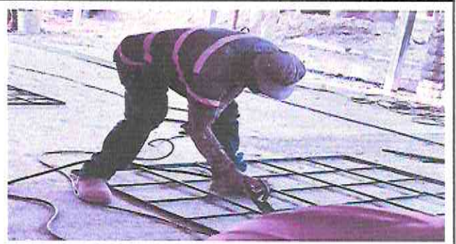
Foto 2: Fabricacion e instalacion de ventana-balcon de metal
