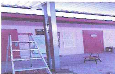
Foto1: Mantenimiento de soporte de metal
