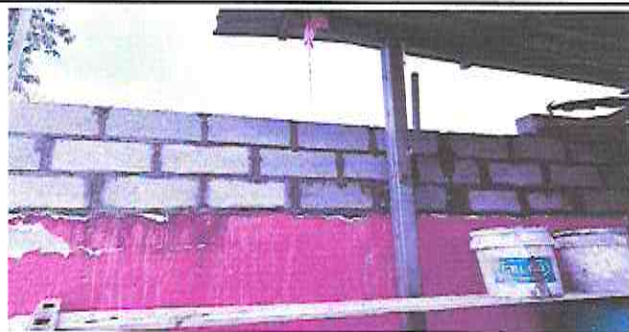
Foto 5: Reparacion de muro perimetral de block
