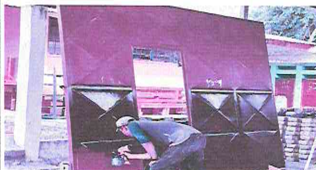
Foto 4: Mantenimiento de portones
