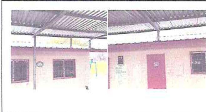
FOTO 1: Reparacion de estructura de techo en el area de salones de clases.
