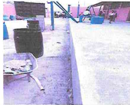
Foto 2: Sustrucion de piso de torta de concreto
