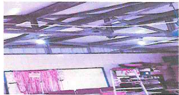
Foto 4: Reparacion de sistema electrico
