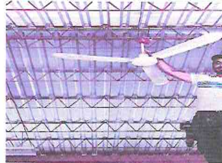
Foto 4: Reparacion de sistema electrico
