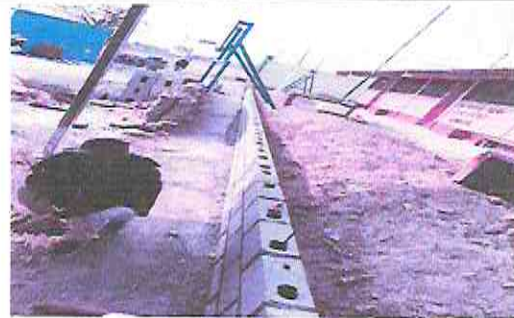
Foto 6: REPARACION DE MURO DE CONTENCIÓN
