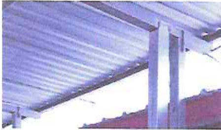
Foto 1: Sustrucion de estructura de madera, por metal
