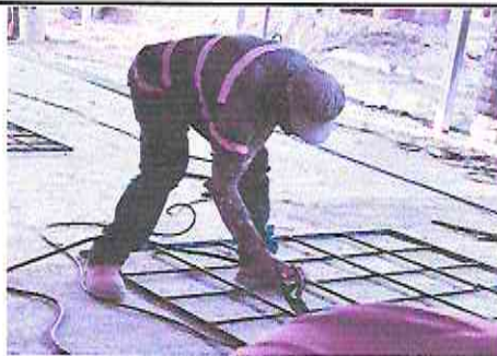
Foto 5: Fabricacion e instalacion de balcones de hierro en ventana
