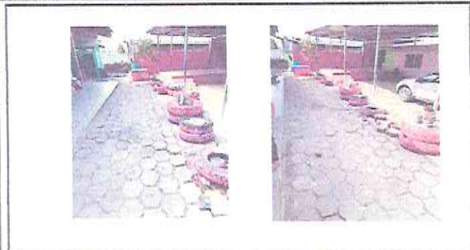
FOTO 1: sustitucion de piso de adoquin por torta de concreto.
