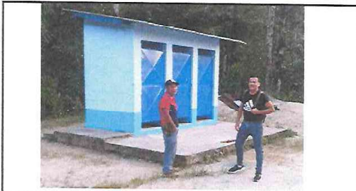
Foto 11: Finalizada la Reparación de Cubierta de Techo de SERVICIO SANITARIOS(LETRINAS). Debe Removerse la Lámina de Asbesto cemento para darle Mantenimiento a la Estructura Existente y Luego Sustituir Lámina Troquelada C26 Legítima. Retiro y Sustitución de Puertas de Metal. Suministro de Pintura Latex.
