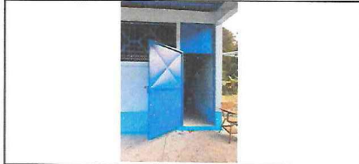
Foto 7: Finalizada el Retiro y Sustitución de Puerta Metálica de AULA PURA.
