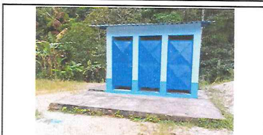
Foto 12: Finalizada la Reparación de Cubierta de Techo de SERVICIO SANITARIOS(LETRINAS). Debe Removerse la Lámina de Asbesto cemento para darle Mantenimiento a la Estructura Existente y Luego Sustituir Lámina Troquelada C26 Legítima. Retiro y Sustitución de Puertas de Metal. Suministro de Pintura Latex.
