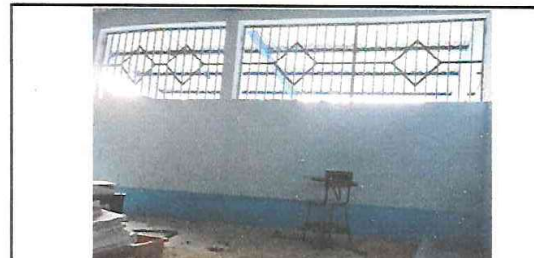
Foto 4: Sustitución de Balcones Metalcos para AULA PURA.
