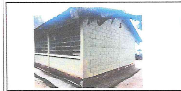
Foto 5: Reparación de Cubierta de Techo. Debe Removerse la Lámina de Asbesto cemento para darle Mantenimiento a la Estructura Existente y Luego Sustituir Lámina Troquelada C26 Legítima, Retiro y Sustitución de Puerta y Balcones. Suministro de Pintura Latex. (VISTA ISOMÉTRICA POSTERIOR AULA PURA).
