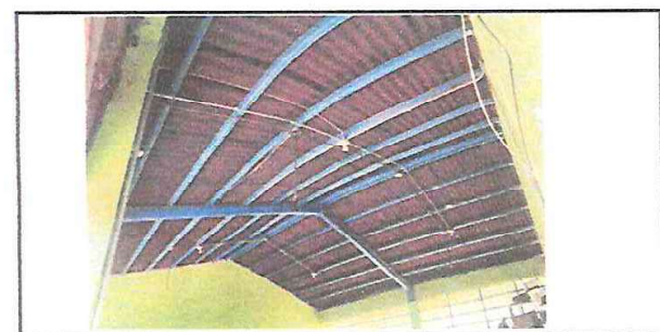
Foto 3: Reparación de Cubierta de Techo de AULA PURA. Debe Removerse la Lámina de Asbesto cemento para darle Mantenimiento a la Estructura Existente y Luego Sustituir Lámina Troquelada C26 Legítima, Retiro y Sustitución de Puerta y Balcones. Suministro de Pintura Latex.
