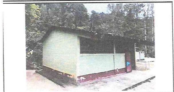
Foto 1: Reparación de Cubierta de Techo de AULA PURA. Debe Removerse la Lámina de Asbesto cemento para darle Mantenimiento a la Estructura Existente y Luego Sustituir Lámina Troquelada C26 Legítima, Retiro y Sustitución de Puerta y Balcones. Suministro de Pintura Latex.
