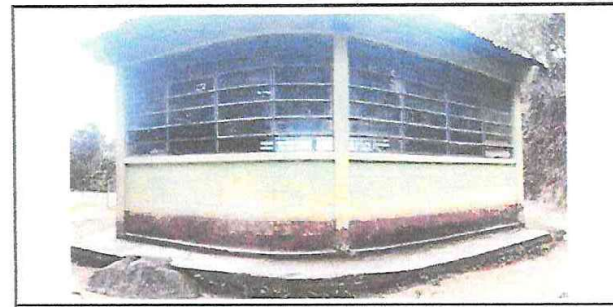
Foto 6: Retiro y Sustitución de Balcones Metalicos de AULA PURA.
