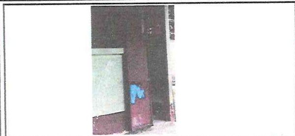
Foto 7: Retiro y Sustitución de Puerta Metálica de AULA PURA.
