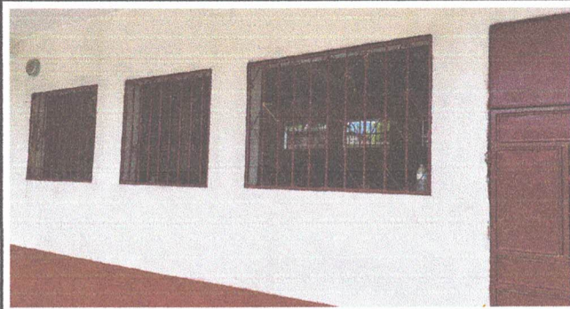
FABRICACION E INSTALACION DE VENTANAS PVC AULA 2
