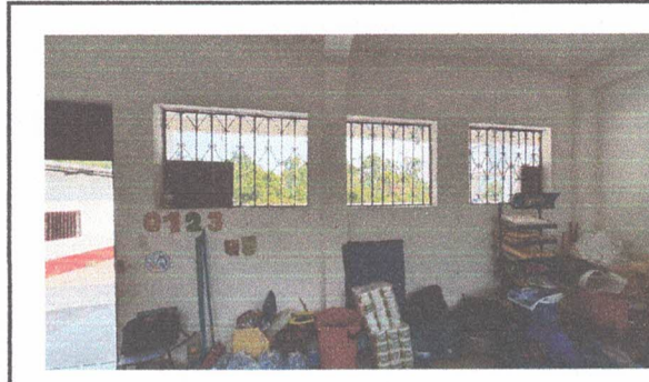
PINTURA EN MUROS EXTERIORES E INTERIORES AULA 1
