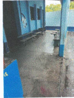
Foto 2: Instalación de piso cerámico
