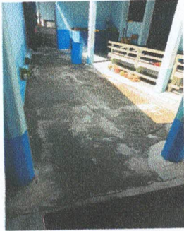
Foto 1: Reparación de torta de cemento
