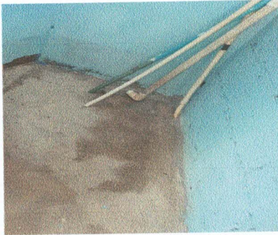
Foto 3: Instalación de azulejo en muros de baños y piso cerámico
