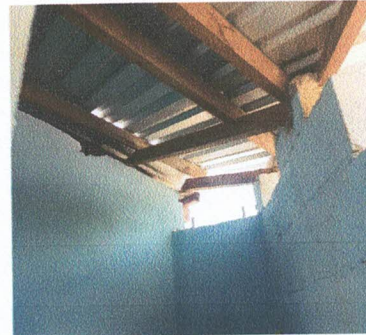
Foto 4: Sustitución de cubierta de lámina baños
