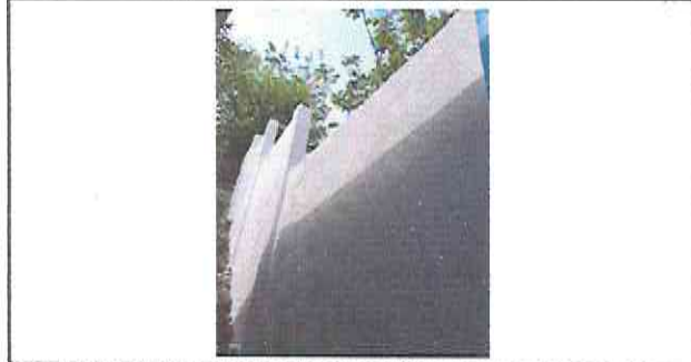
Foto 1: Parte del área donde se le agregó altura al muro perimetral, así como también repello y cernido.
