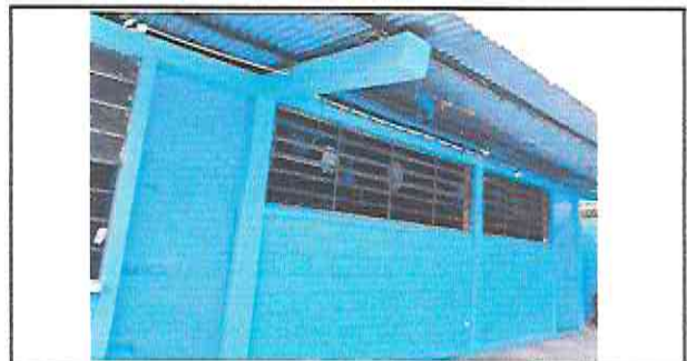
Foto 10: Parte del área donde se le brindó mantenimiento a las puertas.
