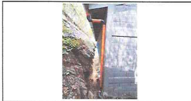
Foto 3: Área donde se instaló canal y tubería para conducción de agua pluvial.
