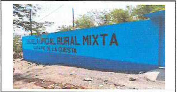
Foto 6: Muro perimetral (principal) frente, rotulado con su respectivo zócalo.
