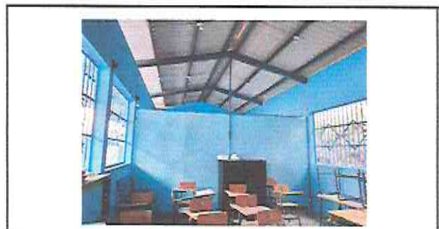
Foto 12: Parte del área donde se pintaron muros exteriores e interiores.
