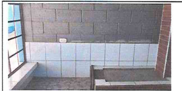
Foto 9: Cambio de plancha de estufa, colocación de azulejo, resanado de paredes y colocación de piso antideslizante.
