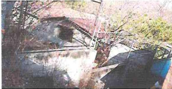
Foto 1: Parte del área donde se le agregará altura al muro perimetral, requiere, repello y cernido.
