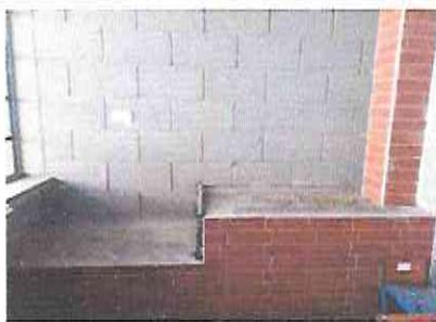
Foto 9: Cambio de plancha de estufa, colocación de azulejo, resanado de paredes y colocación de piso antideslizante.
