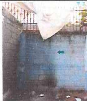
Foto 8: Parte del área donde se le agregará altura al muro perimetral, así como repello y cernido.
