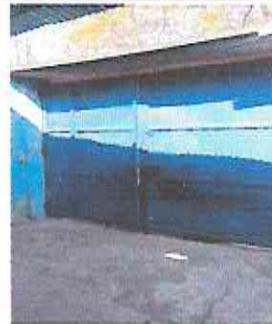
Foto 4: Portón en mal estado, se le dará mantenimiento y se sustituirá chapa por mal funcionamiento.
