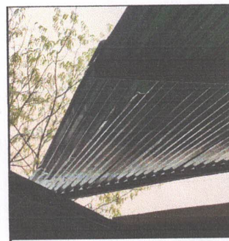
SUSTITUCION DE ESTRUCTURA DE SOPORTE DE METAL POR METAL Y SUSTITUCION DE CANAL PVC
