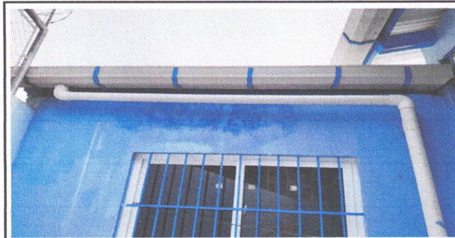
Foto 3: canales y bajadas de agua pluvial repación y mantenimiento de canal
