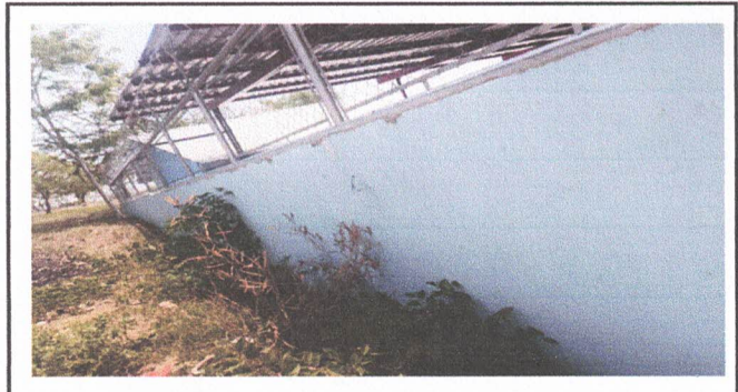
Foto7: reparación de repello y cernido de paredes repello en muro, cernido en muro, alisado en muro
