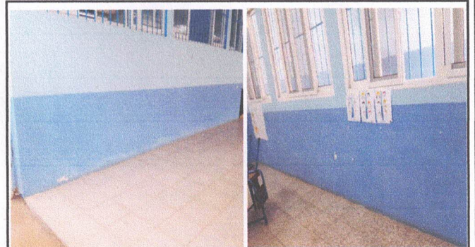
Foto 4: pintura en muros exterior y interior aulas escenario
