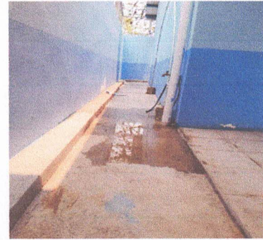
Foto 2: sustitución de piso de torta de concreto por falta de desnivel
