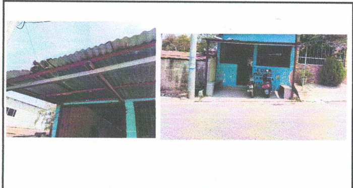
1.4 SUSTITUCIÓN E INSTALACIÓN DE GALERA (entrada principal)
