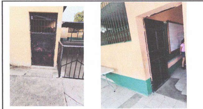
4.1 MANTENIMIENTO A PUERTAS
