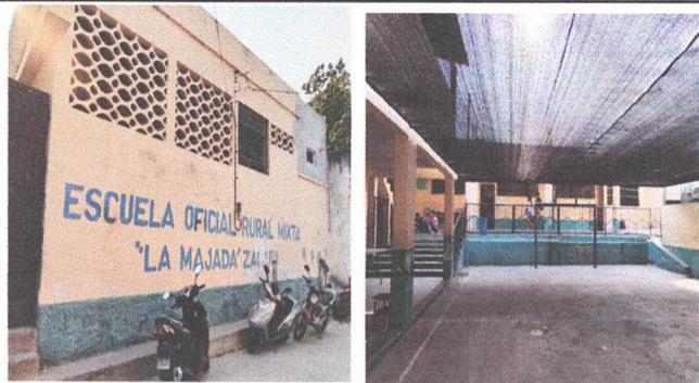
4.5 SUMINISTRO Y APLICACIÓN DE PINTURA EN MUROS INTERIORES Y EXTERIORES
