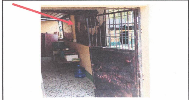
3.1 FABRICACIÓN E INSTALACIÓN DE MOSQUITERO
