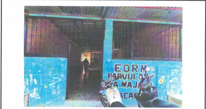
1.3 REPARACIÓN DE PARED Y SUSTITUCIÓN DE CERNIDO (entrada principal)
