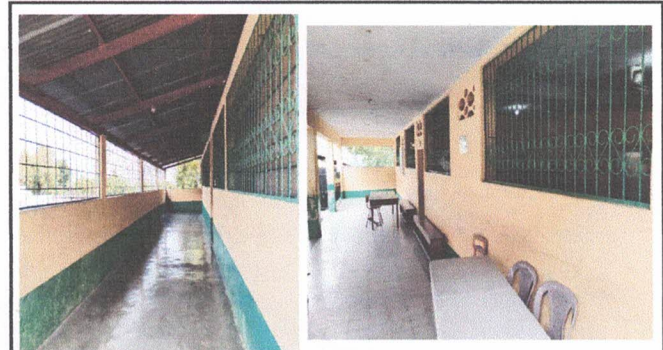
4.2 MANTENIMIENTO A BALCONES
