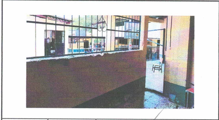
1.1 FABRICACIÓN E INSTALACIÓN DE PUERTA
