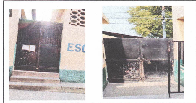
4.4 MANTENIMIENTO A PORTÓN
