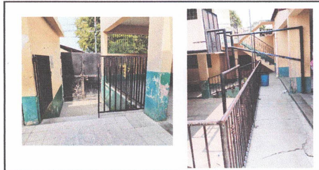
4.3 MANTENIMIENTO A BARANDAS
