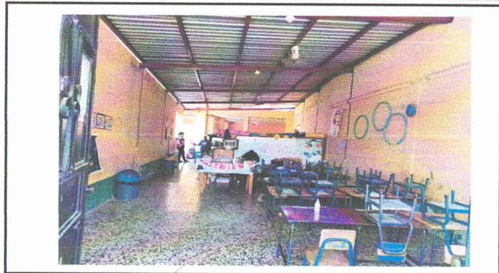
1.2 MANTENIMIENTO Y SUMINISTRO DE MATERIAL PARA REPELLO DE PAREDES
