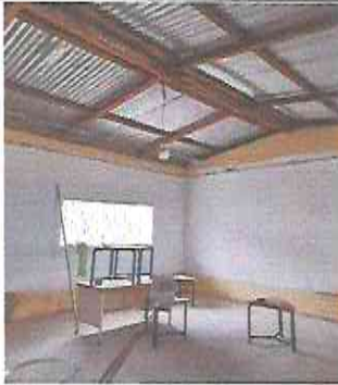
Foto 1: Instalación de cielo falso e instalación de iluminación aula 1.
