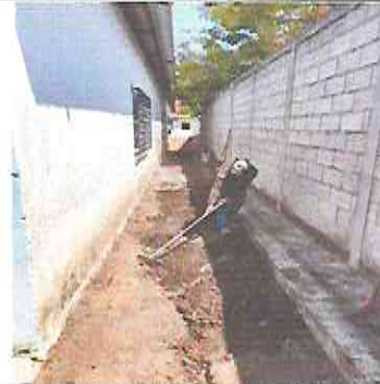
Foto 4: Sustitución de piso nuevo en torta de concreto parte trasera aula 1.
