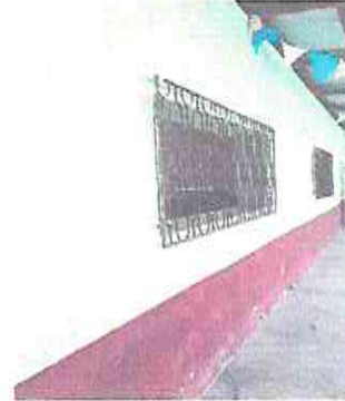
Foto 8: Mantenimiento de balcones. Fuente: Dirección del establecimiento
