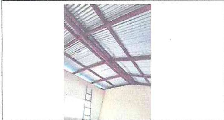
Foto1: Instalación de cielo falso e instalación de iluminación aula 1. Fuente: Dirección del establecimiento
