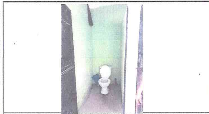
Foto 5: Instalación de azulejos en sanitario. Fuente: Dirección del establecimiento
