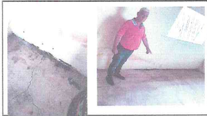
Foto 3: Sustitución de piso de torta de concreto e instalación de piso ceramico aula 1. Fuente: Dirección del establecimiento
