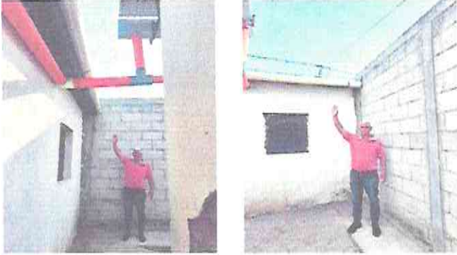
Foto 7: Espacio donde se fabricará e instalará base elevado para tanque de agua 1. Fuente: Dirección del establecimiento
