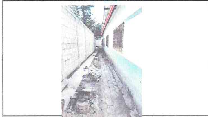
Foto 4: Sustitución de torta de concreto e instalación de piso nuevo en torta de concreto parte trasera aula 1. Fuente: Dirección del establecimiento
