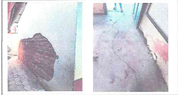
Foto 2: Sustitución de repellos y elaboración de repellos y cernidos en parte lateral izquierda aula 1. Fuente: Dirección del establecimiento
