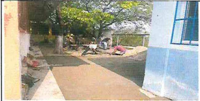
FOTO 10: REGLON 4.1 SUSTITUCION DE PLANCHA DE CONCRETO
