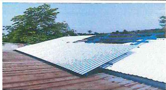
Foto 4: REGLON 1.1 INSTALACION OSUSTITUCION DE LAMINA POR LAMINA TROQUELADA ALUZINCIELA CALIBRE 26
