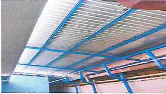
FOTO 12 REGLON 1.1 INSTALACION O SUSTITUCION DE LAMINA TROQUELADA
