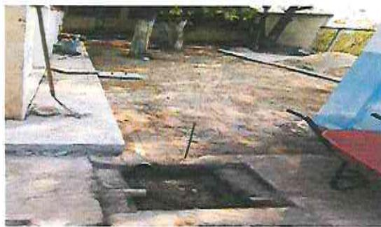
FOTO 9 REGLON 4.1 SUSTITUCION DE PLANCHA DE CONCRETO
