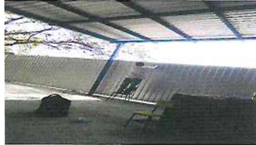
FOTO 13 REGLON 1.1 INSTALACION O SUSTITUCION DE MAYA POR LAMINA TROQUELADA
