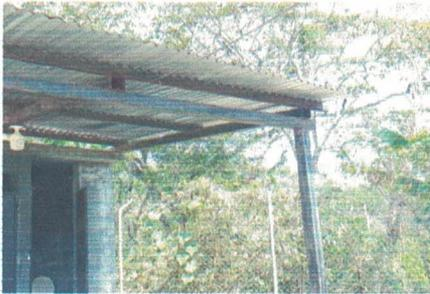
Foto 9: Baño Instalación de estructura de soporte de metal (incluyendo columnas de metal).
