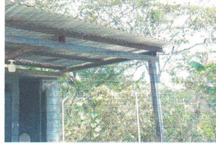
Foto8: Baño Instalación de lámina troquelada calibre 26
