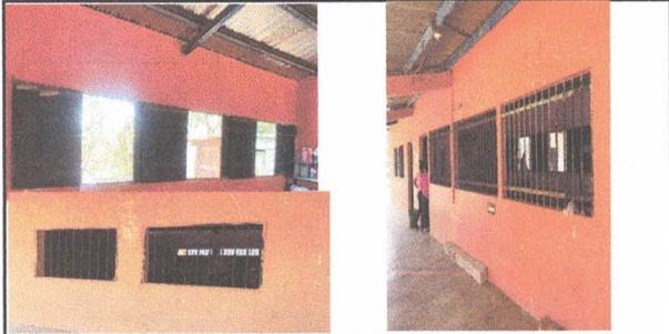
SUSTITUCION DE BALCONES DE METAL, SUSTITUCION DE ESTRUCTURA DE METAL DE VENTANA Y MANTENIMIENTO A ESTRUCTURA DE METAL DE VENTANA
