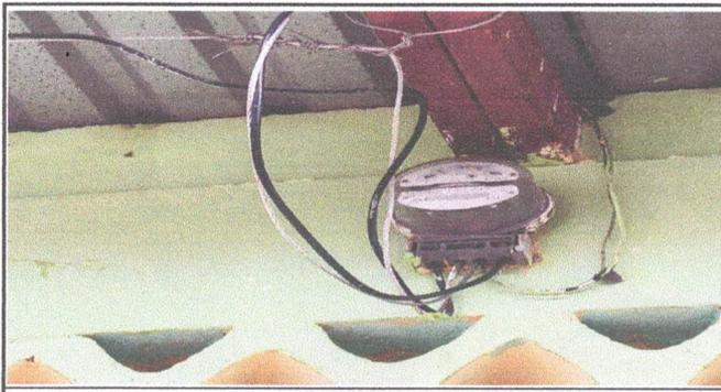
Foto 5: Instalación de acometida eléctrica
