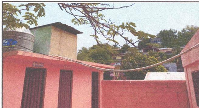
Foto 2: Daños en el sistema de tubería en el área de sanitarios de preprimaria.
