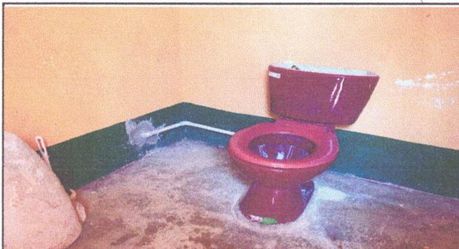
Foto 3: Estado actual del deterioro de los sanitarios de preprimaria.
