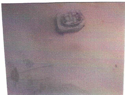
Foto 15: Sustrucción de toma corrientes dobles
