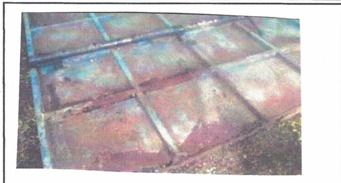
Foto 2: sustitución de Porton
