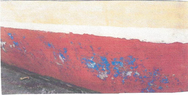
Foto 7 : pintura en interiores y exteriores
