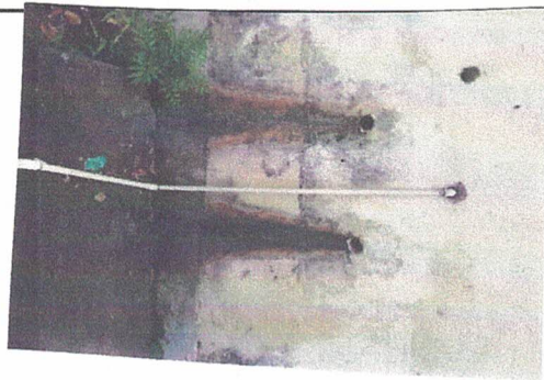
Foto 9 : Sustitución de tubería PVC línea principal aguas pluviales
