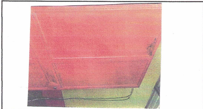
Foto 1 : sustitución de puerta
