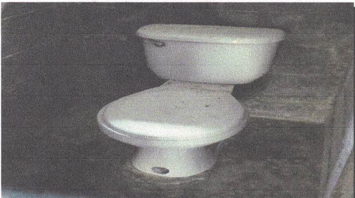
Fotografía 9. Sustitución de inodoro e instalación de piso cerámico.
