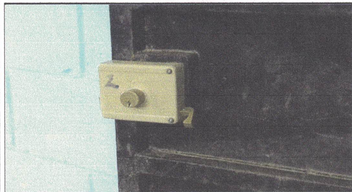
Fotografía 3. Sustitución de chapa en puerta.
