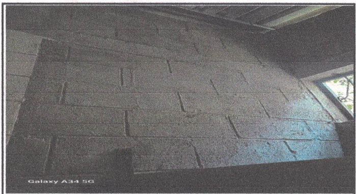
Fotografía 10. Pintura de muros exteriores e interiores.
