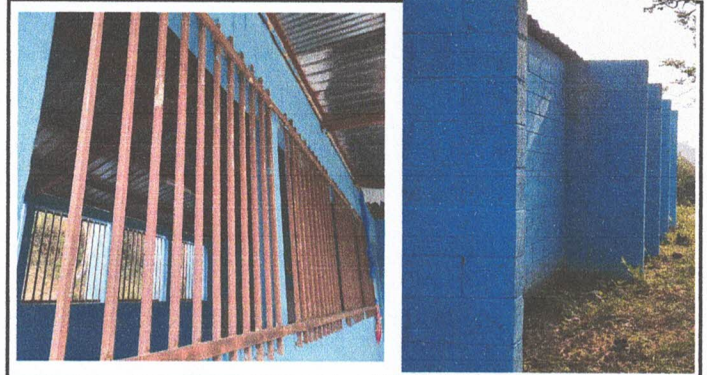
PINTURA DE MUROS EXTERIORES E INTERIORES
