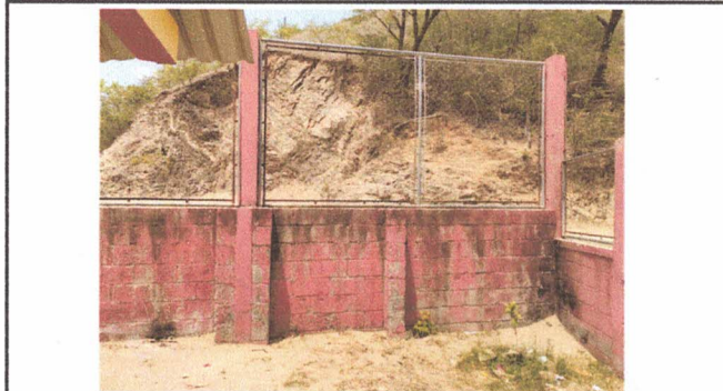
Foto 10: Sustitución o instalación de muros.
