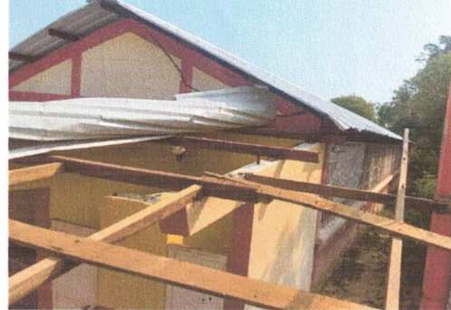
Foto 2: Sustitución de estructura de soporte de metal
