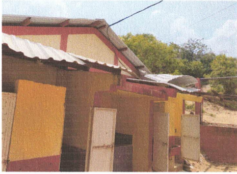
Foto 1: Sustitución de lámina troquelada
