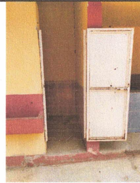
Foto 4: Sustitución de inodoro.
