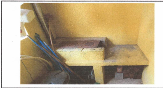
Foto 12: Sustitución de mueble de concreto.
