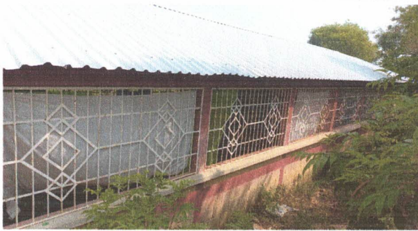
Foto 3: Instalación de canal de metal
