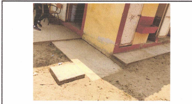
Foto 8: Remozamiento de fosa séptica
