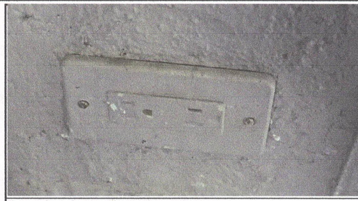
Fotografía 2. Sustitución de tomacorrientes.
