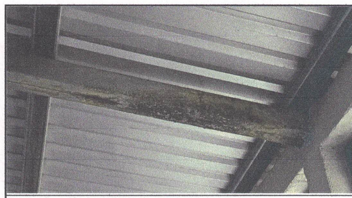
Fotografía 4. Mantenimiento de estructura de soporte.
