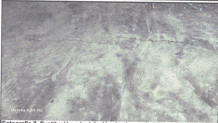
Fotografía 7. Sustitución o instalación de pizo cerámico
