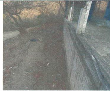
Foto 2: Se deberá Corregir la Corona superior del Muro de Contención, Tallar y Repellar con Base Gris.
