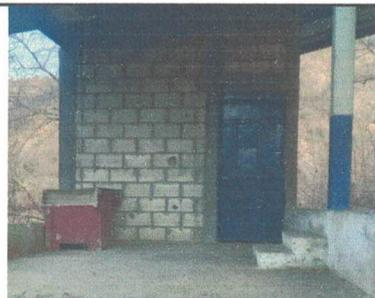
Foto 5: Fundición de Piso de Concreto en Mal Estado Patio, y Cerramiento de Vano o Puerta para Trasladarla hacia lado Derecho de su ubicación Actual. Y para la Cocina se Instalará Piso de Granito.
