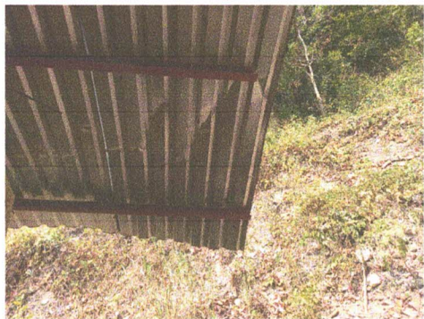
Foto 1: Sustitución de Lámina
