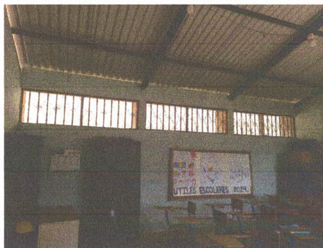
Foto 2: Sustitución de Estructura de soporte de metal.
