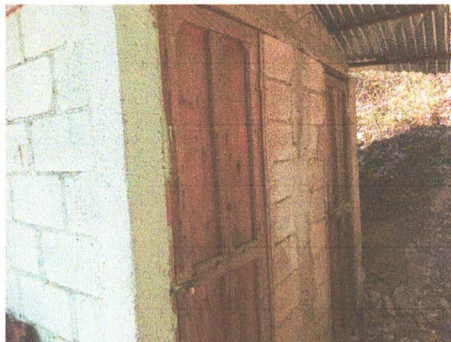
Foto 4: Sustitución de Puerta de servicios sanitarios
