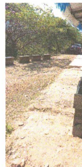
Foto 8: Sustitución de Piso de concreto
