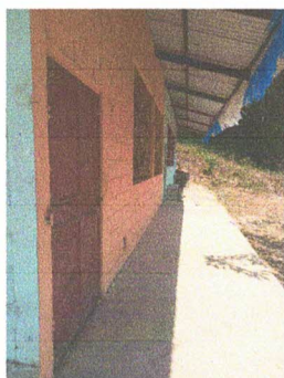
Foto 3: Sustitución de puertas
