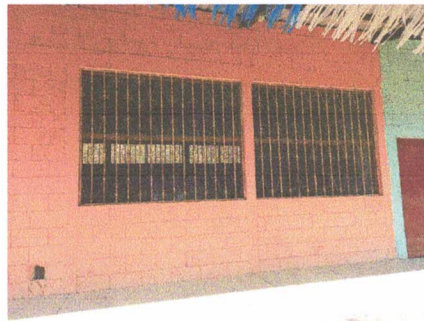
Foto 6: Mantenimiento a Balcones de metal
