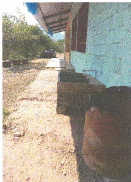
Foto 7: Reparación de banquetas de concreto
