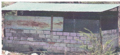
Foto 1: Sustitucion de lamina por lamina troquelada
