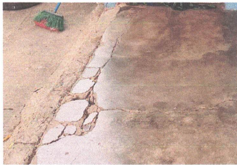
AREA DE EXTERIORES: SUSTITUCIÓN DE PISO DE CEMENTO LIQUIDO
