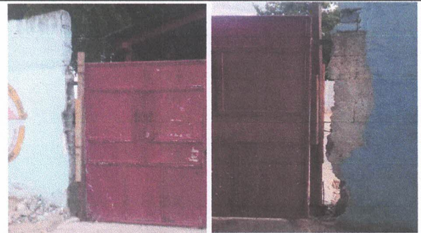
AREA DE EXTERIORES: REPARACIÓN DE COLUMNAS DE MURO PERIMETRAL. (BARILLAS PODRIDAS).
