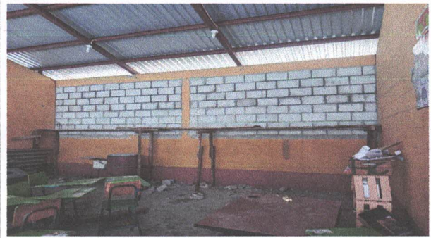
AREA DE EXTERIORES: PINTURA EN MUROS
