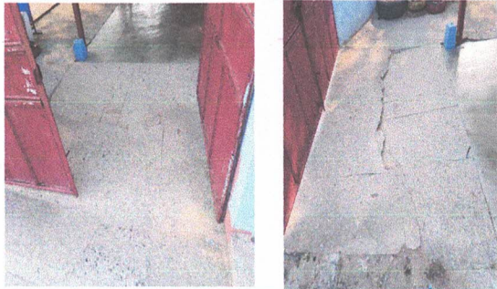
AREA DE EXTERIORES: SUSTITUCIÓN DE LOSA DE CONCRETO DE PATIO
