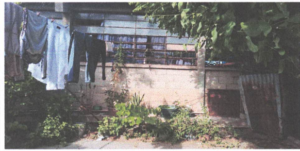
AULAS: CERRAMIENTO DE VANO CON BLOCK (4 VENTANAS DE 4.10 X 2.10 C/U)
