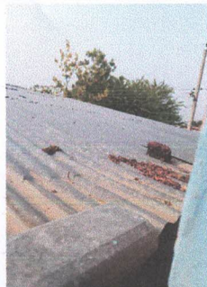
BODEGA: SUSTITUCION DE CANAL DE METAL A CANAL PVC
