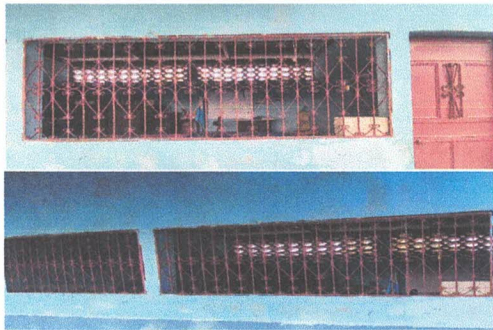
AULAS: MANTENIMIENTO A BALCONES DE METAL
