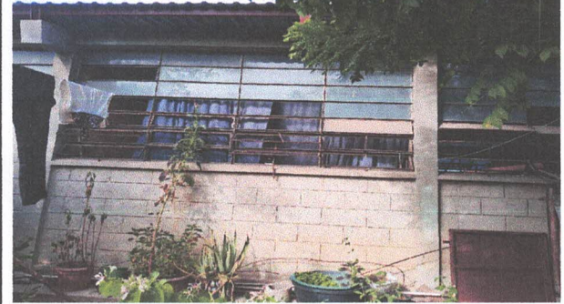
AULAS: CERRAMIENTO DE VANO CON BLOCK (4 VENTANAS DE 4.10 X 2.10 C/U)
