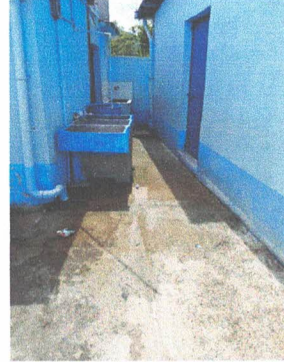
Foto 2: Fabricacion e instalacion de canal y sus bajadas.
