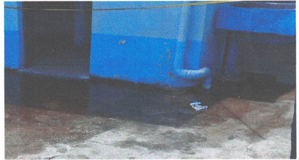
Foto 4: Sustrituion de tuberia pvc lineal principal de aguas negras en piso de torta.
