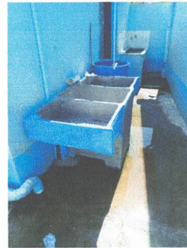
Foto 6: Instalacion de pila.
