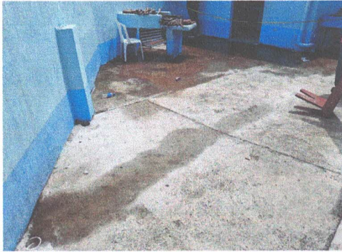
Foto1: Sustrituion de piso de torta de concreto.
