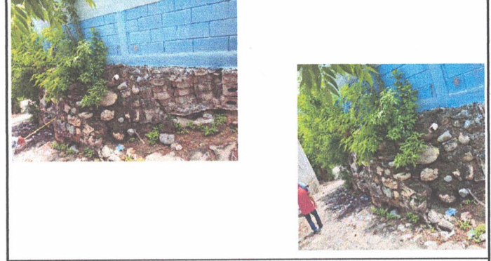
Foto 2: Reparación de muro de contención, aplicación de sabieta en muro de contención y aplicación de repello en muro de contención.
