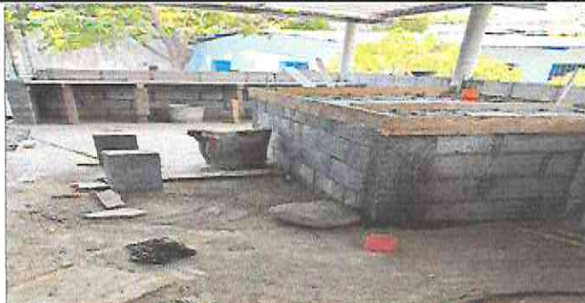
Foto 2: mantenimiento de pila y en polletón, sustitución de ventanas por balcones.
