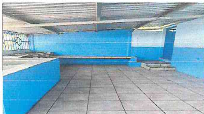
Foto 3: mantenimiento en cocina
