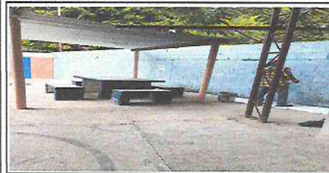
Foto 5: sustitucion y mantenimiento de pintura en paredes del exterior del establecimiento.
