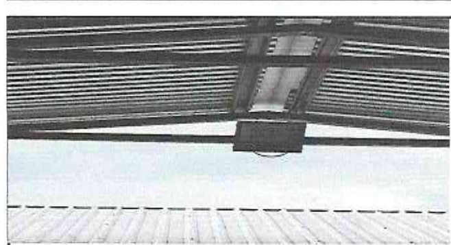
Foto 6: instalación de unidad de iluminación.
