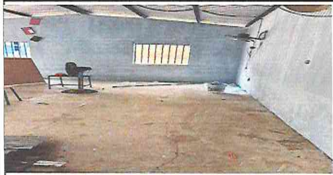
foto 1: sustitucion y mantenimiento de pintura en aula.
