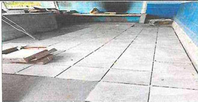
MANTENIMIENTO PISO DE LA COCINA
