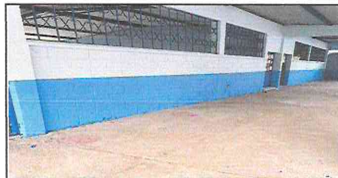
Foto 4: fase final de pintura en corredores.
