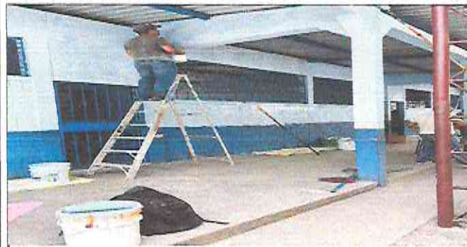
foto3: sustitucion y mantenimiento de pintura en corredores
