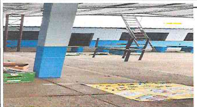
Foto 5: sutitucion y mantenimiento de red eléctrica en galera.
