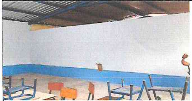
Foto 2: fase final en pintura de aula.
