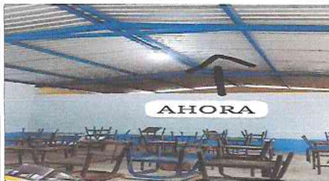
Foto 3: pintado e intalado el techo de lamina troquelada.
