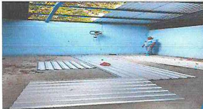
Foto 2: se pinto e instaló de cubierta de lámina troquelada Aluzinc a dos aulas.
