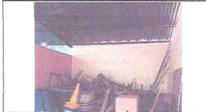
Foto 2: Mantenimiento a estructura de techo e instalación de Cubierta de Lamina Troquelada Aluzinc para 2 AULAS.
