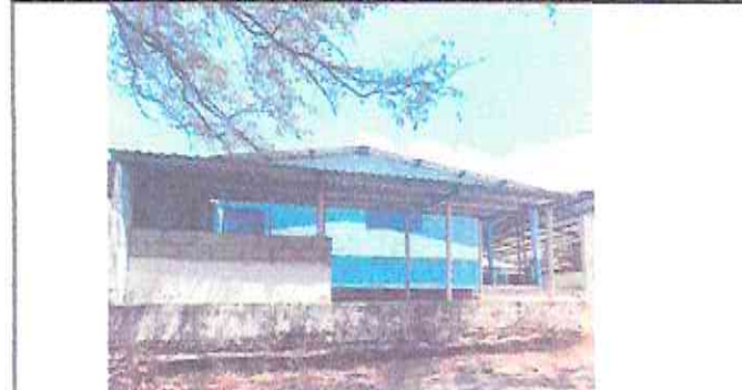
Foto 4: Reparación de Cocina.
