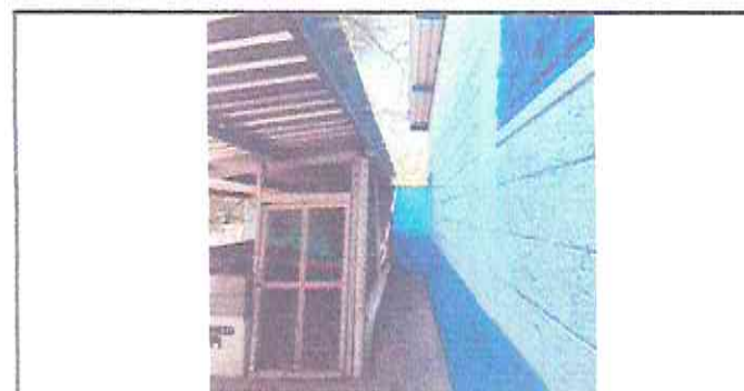
Foto 6: Reparación de Cocina.
