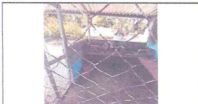
Foto 5: Rehabilitación de Cocina.
