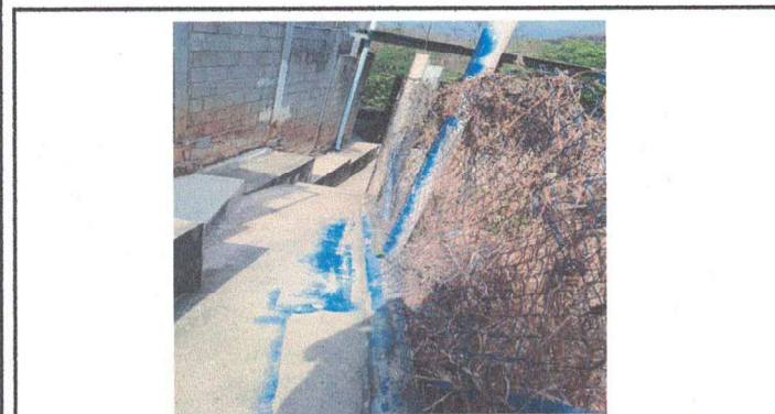
Foto 3: Reparación de muro perimetral que por la lluvia se cayó.
