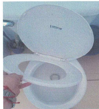
Foto 2: Sustitución de tapadera de sanitario.
