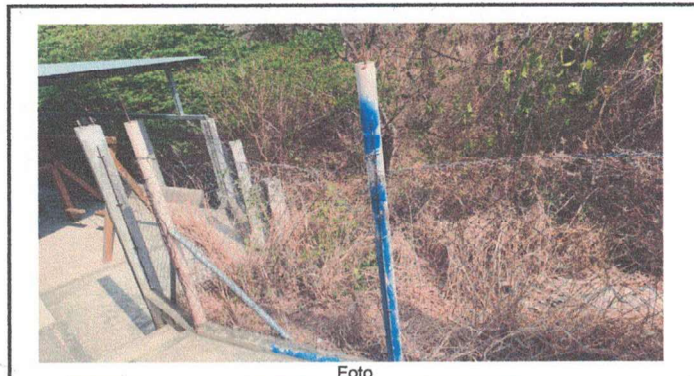
Foto 4: Reparación de muro perimetral en la parte de atrás de la escuela.
