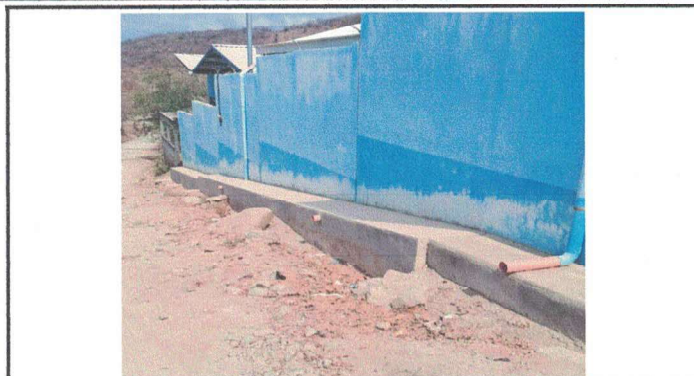
Foto 2: Pintura de la escuela en todos sus exteriores.
