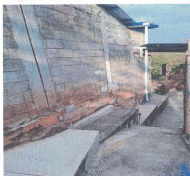
Foto 3: Repello de muro.
