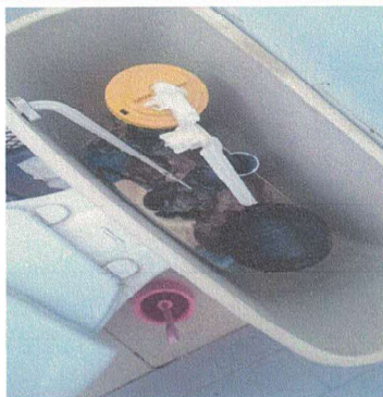
Foto 1: Cambio de accesorios de inodoros.
