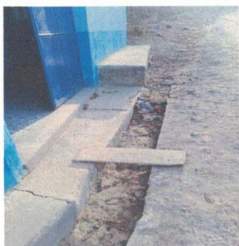
Foto 3: Reparación de cuneta de concreto.
