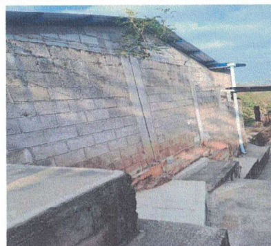
Foto 4: Reparación de muro perimetral en la parte de atrás de la escuela.
