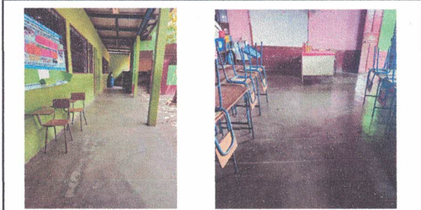
Foto 1: 9.1 Aula y Corredor Cambio de Piso.
