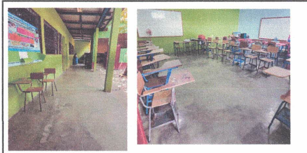
Foto 3: 9.1 Cuatro Aulas y Dirección Cambio de Piso.
