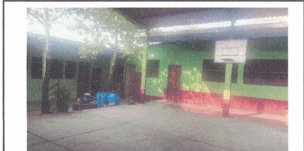
Foto 4 : 9.1 Exterior Aplicación de Pintura
