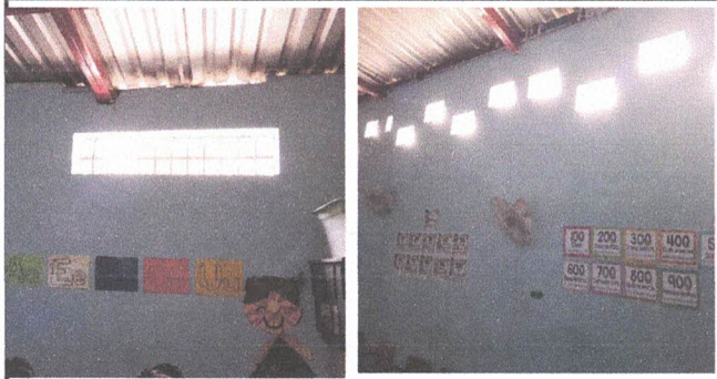
Foto 7: Elaboración de balcones para sustituir por unos de mayor tamaño para lograr la iluminación en las aulas 1, 2, 3 y 4.
