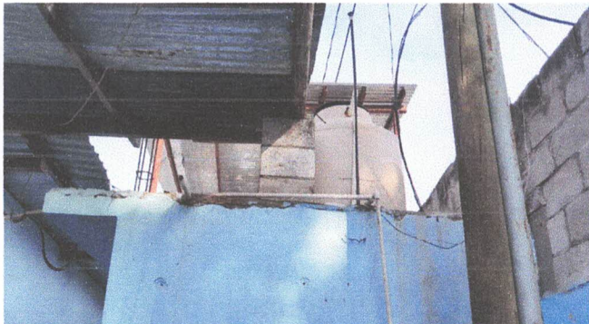
Foto 4: Sustitución de depósito de agua por uno de más capacidad acorde a la población estudiantil del establecimiento.
