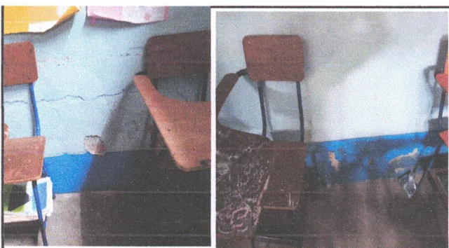
Foto 5: Reparación de repello y cernido en aula 1 debido al mal estado de este por la humedad.
