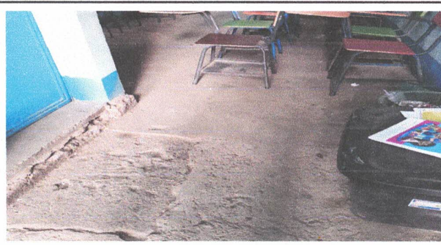
Foto 2: Sustitución de piso de cemento por piso cerámico en aula 1, 2, 3, 4, 5 y pasillo.
