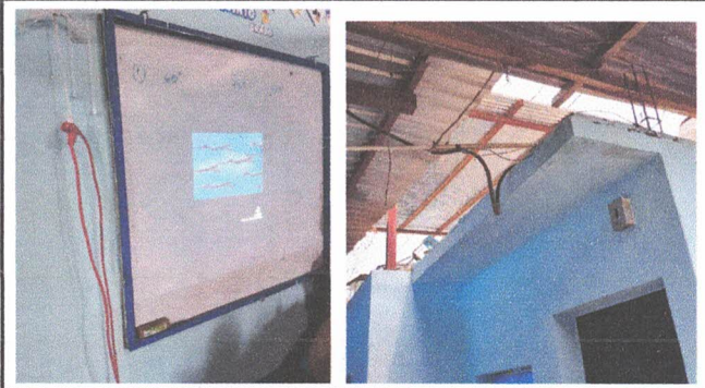
Foto 8: Reparación del sistema eléctrico en todos los salones agregando tomacorrientes en todos los salones.
