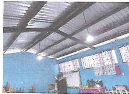
Foto 6: Intalación de lámina troquelada aluzinc , mantenimiento de costaneras y sustitución de focos ahorradores.
