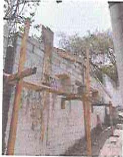
Foto 7: Reparación de muro perimetral de block
