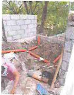
Foto 9: Instalación de tubería de drenaje de inodoros
