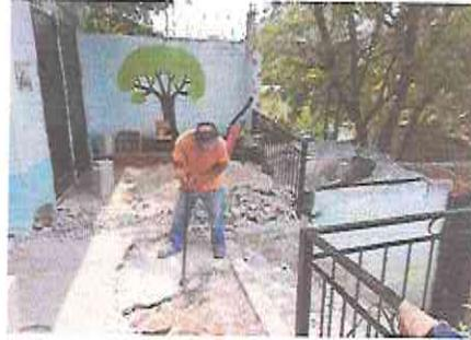
Foto 8: Sustitución de torta de cemento
