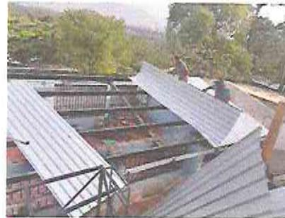
Foto 6: Instalación de lámina troquelada aluzinc
