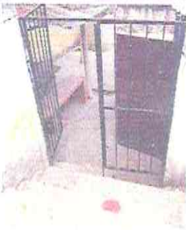
Foto 5: Mantenimiento a portones de metal
