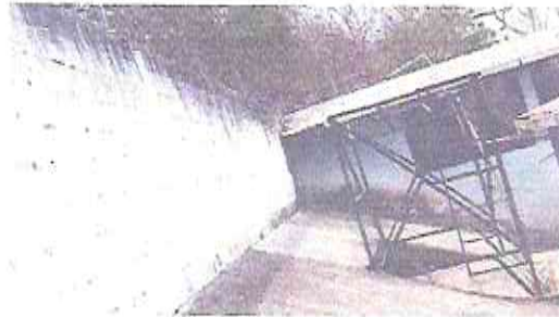
Foto 2: Reparación de muro perimetral de block.
