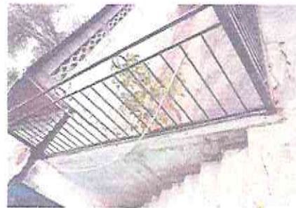
Foto 6: Mantenimiento a barandas de metal
