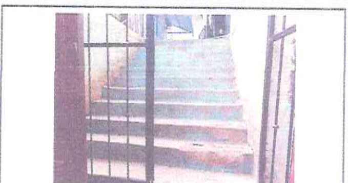
Foto 10: Sustitución de cemento en las gradas
