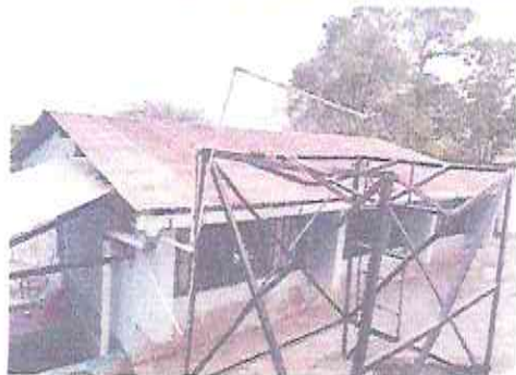
Foto 13: Sustitución de depósito de agua 1 100 lt
