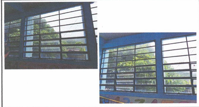
Foto 2: Sustitucion de estructura de metal de ventanas.
