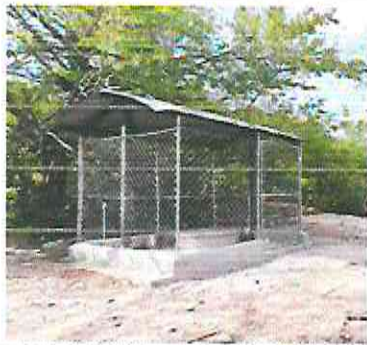
FOTO 3 REPARACIÓN TUBO HG Y MALLA GALBANIZADA
