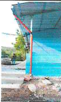
FOTO 11 INSTALACIÓN DE CANAL
