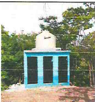
FOTO 9 PINTURA AREA DE BAÑOS
