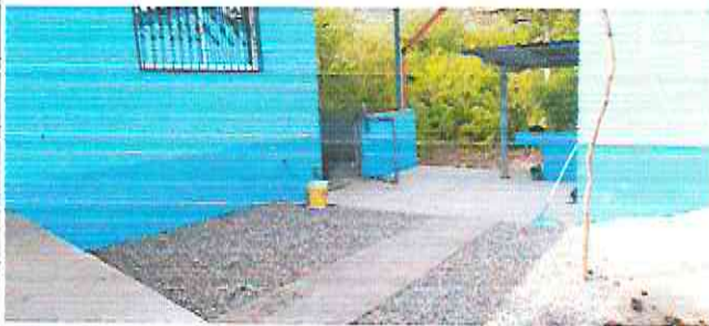
FOTO 5 PUERTA DE REJAS E INSTALACIÓN DE PILA
