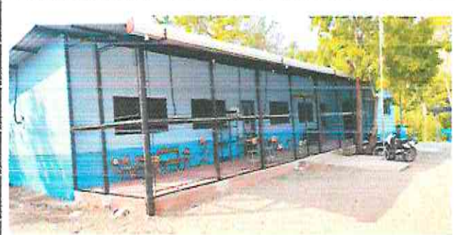
FOTO 2 PINTURA EXTERIOR E INTERIOR
