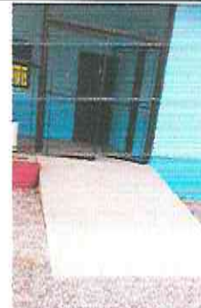
FOTO 4 REPARACIÓN DE RAMPA
