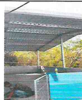
FOTO 6 INSTALACIÓN ESTRUCTURA METALICA E INSTALACIÓN DE LAMINA ALUCIN
