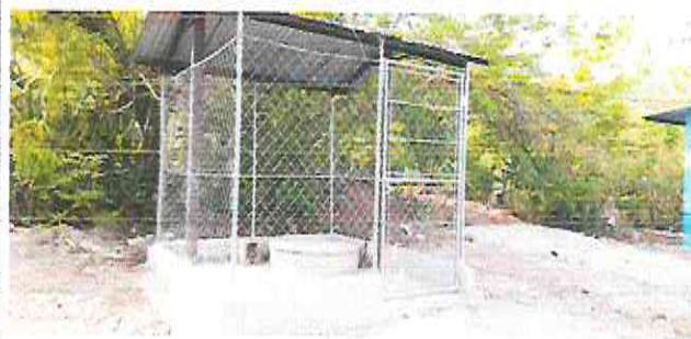
FOTO 12 INSTALACIÓN DE PUERTA DE REJA EN EL ÁREA DE POZO
