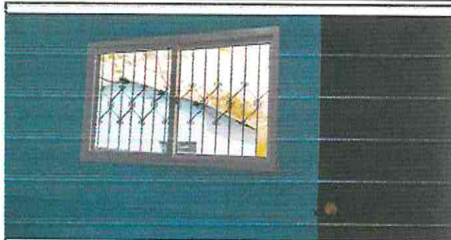
FOTO 8 INSTALACIÓN DE VENTANAS PVC
