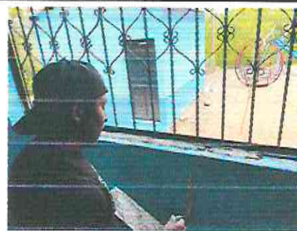
FOTO 6 INSTALACIÓN DE VENTANAS PVC
