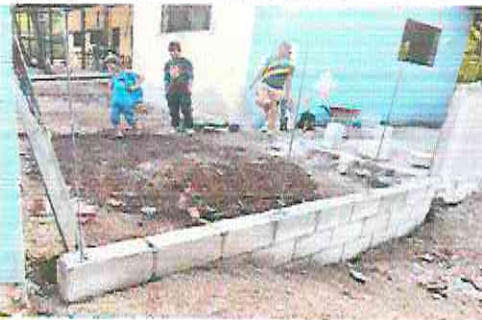
FOTO 11 REPARACIÓN DE MURO CODNTENCIÓN
