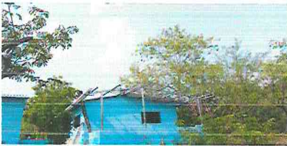
FOTO 9 INSTALACIÓN DE ESTRUCTURA METALICA
