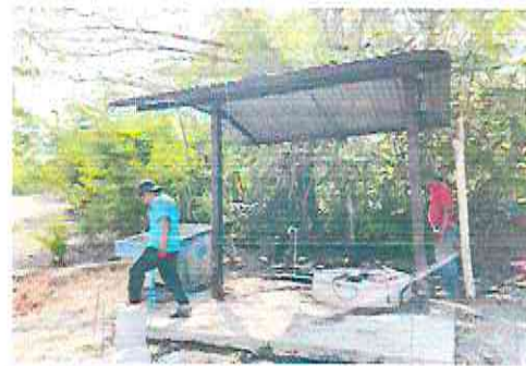
FOTO 4 REPARACIÓN TUBO HG Y MALLA GALBANIZADA
