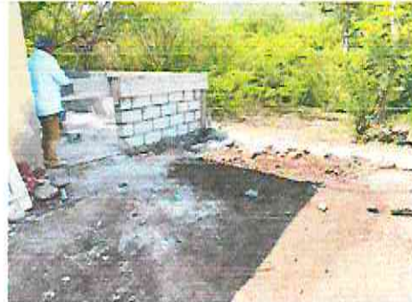
FOTO 2 REPARACIÓN DE MURO DE CONTENCIÓN
