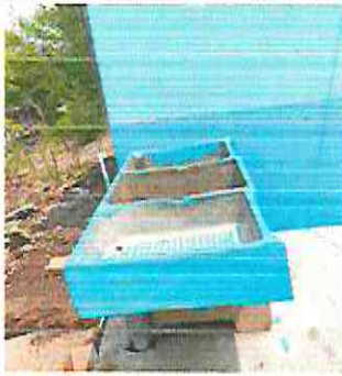
FOTO 7 INSTALACIÓN DE PILA
