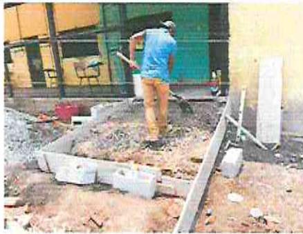
FOTO 1 REPARACIÓN DE RAMPA
